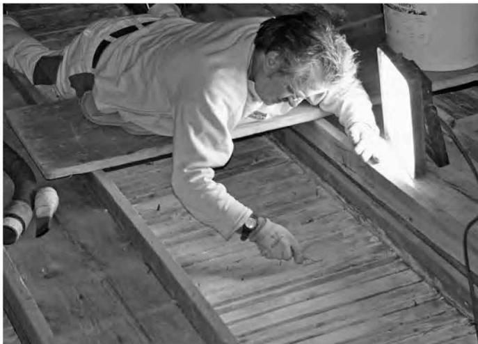
Die sogenannte Bockshaut – sie besteht aus speziellem Mörtel und trägt die Stuckdecke – muss entfernt und wieder neu aufgebaut werden.
