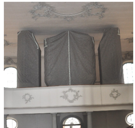
Die bereits eingepackte Orgel wird noch mit Brettern zusätzlich geschützt.
