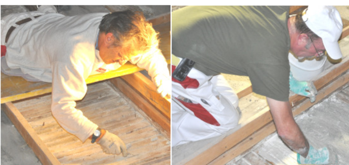
Innenrenovation der Kirche: aufwendige Erneuerung der Decke
